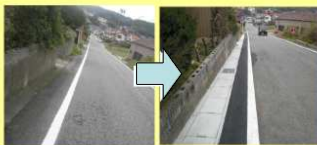
路肩・側溝の整備
