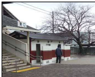
バリアフリーの多目的トイレ
