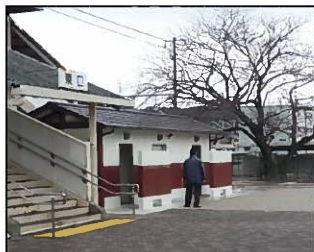
バリアフリーの多目的トイレ
